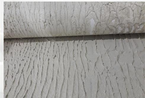
Eine vollflächige Überarbeitung der Abdichtungsbahnen mit der Verbundabdichtung ist nicht erforderlich.
