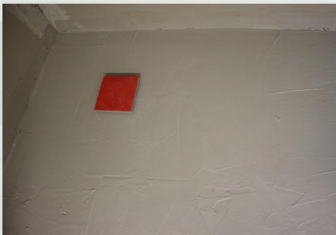
„Frisch in Frisch“ wird die Verbundabdichtung mittels geeigneter Zahnpachtel auf die Kontaktschicht aufgezogen.
