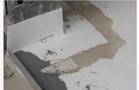
Auf dem Untergrund ist eine Kontaktschicht mit der Verbundabdichtung herzustellen.
