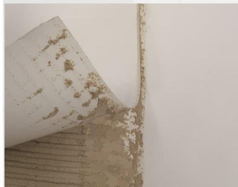
Optional können die Abdichtungsbahnen auch stumpf gestoßen, und die Stöße mit einem vom Hersteller freigegebenen Dichtband und der Verbundabdichtung wasserdicht hergestellt werden.
