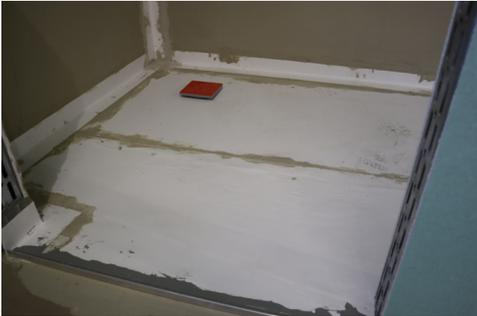
Das Verkleben der Systemkomponenten, wie z. B. Dichtbänder oder Formteile, muss entweder mit der Verbundabdichtung oder mit einem im System geprüften Klebstoff wasserdicht erfolgen.
