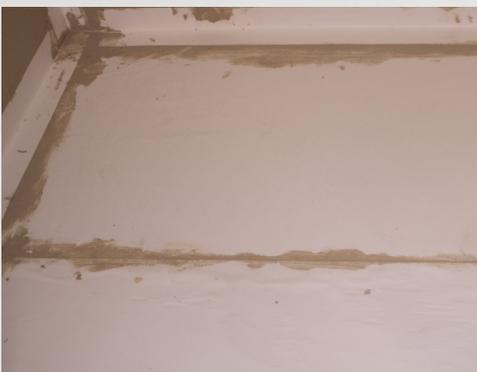
Im Stoßbereich sind die einzelnen Abdichtungsbahnen überlappend anzubringen (mind. 5 cm Überlappung) und mit der Verbundabdichtung oder mit einem im System geprüften Klebstoff (MS Polymer) wasserdicht zu verkleben.
